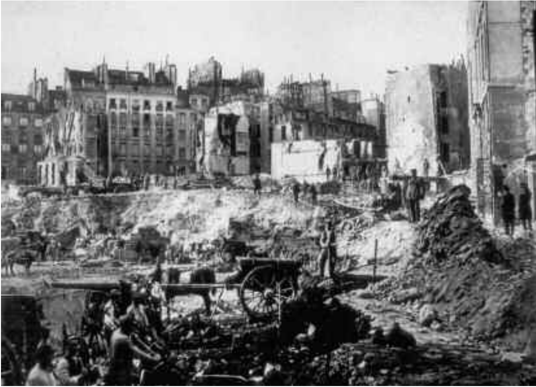
Construcción de l'Avenue de l'Opéra y Boulevard Henri IV. Avenue de l'Opéra. Cantera de la Butte du Moulin y de la rue Saint-Roch, Charles Manville, 1862
