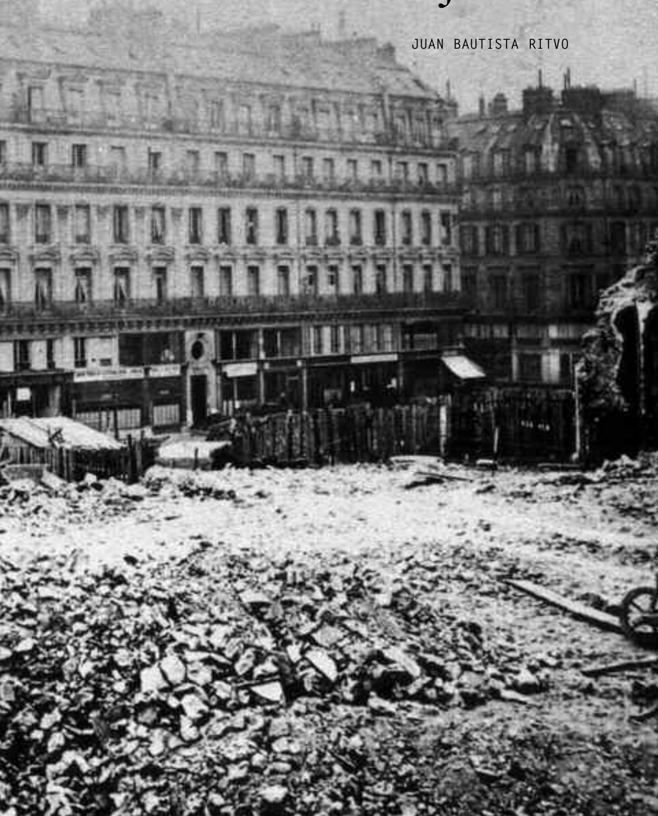
Demolición de Bitte des Moulins para abrir la Avenue de l'Opéra, P. Emonts, ca. 1870
